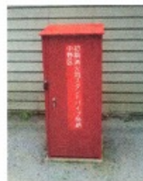
スタンドパイプ
